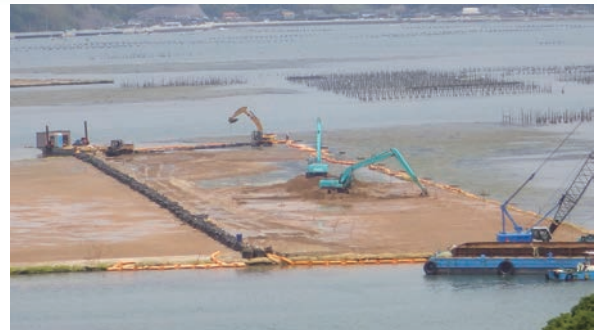
図7 万石浦広瀬南地区に造成中の人工干潟 （2016年6月）
