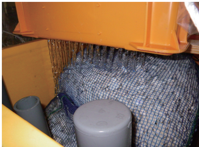
サンゴ砂とガラスリングの濾材設置状況 (千歳事業所)
