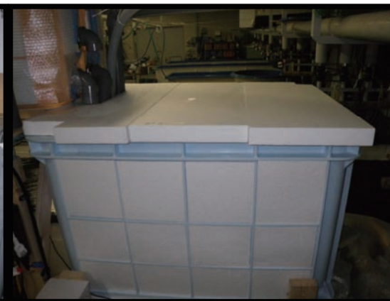
2段目濾過槽は発泡スチロールで保温
